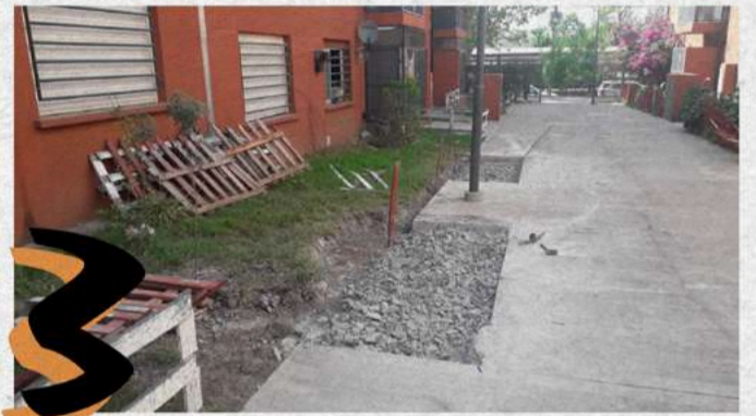
3 PREPARAR EL ÁREA PARA COLOCAR EL NUEVO PISO
