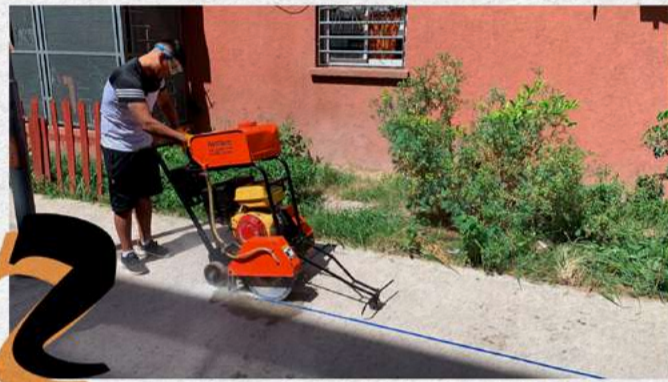
2 CORTAR O RETIRAR EL PISO IMPERMEABLE EXISTENTE
